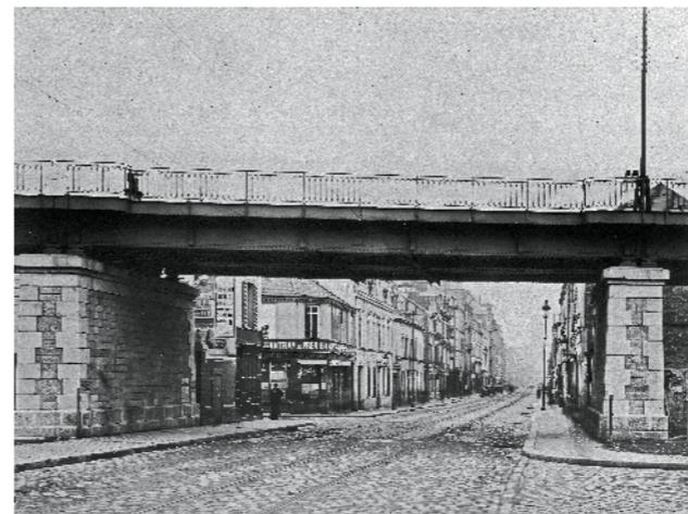
Traversée de la rue Lafayette. Construit par la Compagnie des chemins de fer de l'Ouest, ce viaduc métallique comprend 21 travées sur 351 m de longueur. Il a fallu 20 mois pour le réaliser, de mars 1896 à décembre 1897 (photo R. Reinwillier, Rouen, coll. ADSM, album « Viaduc de Rouen »).
