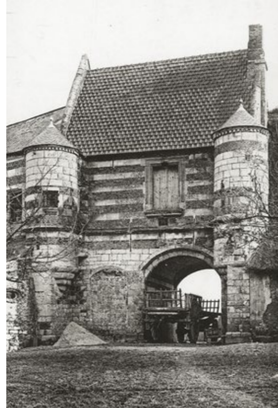
Criquetot-le-Mauconduit, une entrée de ferme avec une porte charretière (fonctionnelle) et une porte piétonnière (murée).
