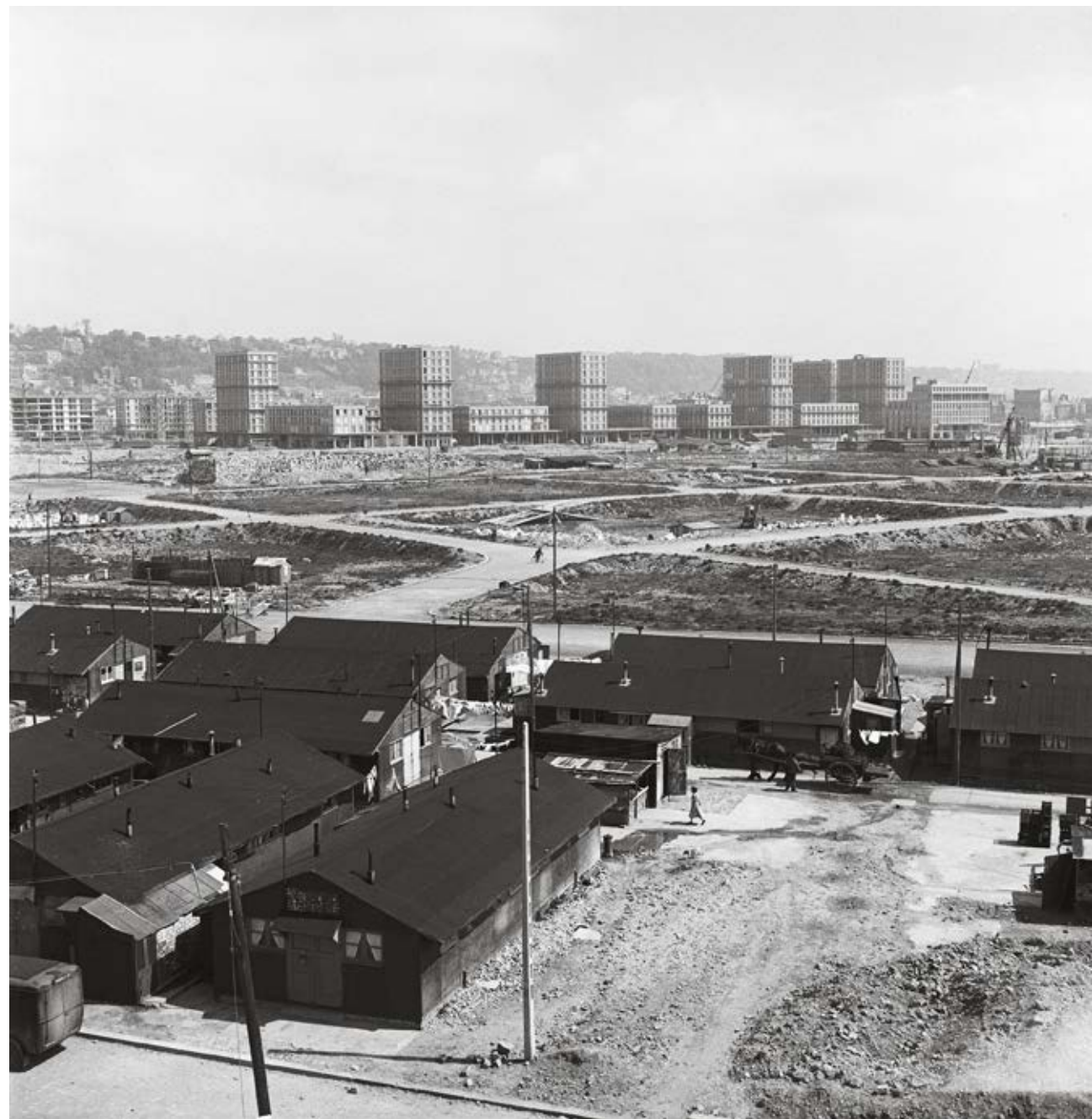
Pendant plusieurs années, vont cohabiter les baraquements provisoires et les immeubles de la ville définitive. Vue prise en mai 1951 par Henri Salesse, alors que les premiers appartements ont été livrés six mois plus tôt.
