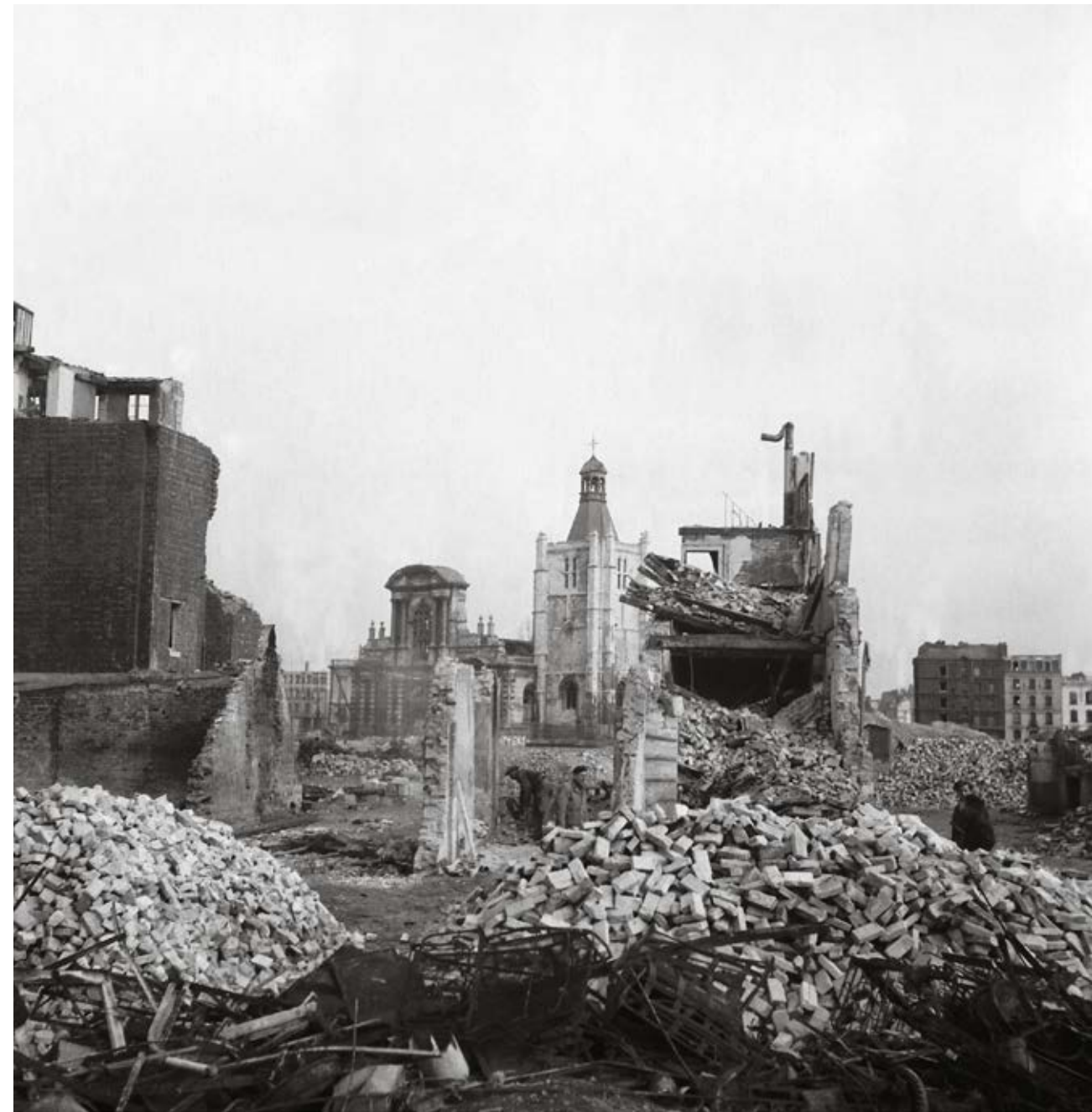
Ruines de la cathédrale Notre-Dame (1946) reconnaissable à sa tour et sa façade. Le bâtiment pourra être sauvé. Au premier plan, des tas de briques et cailloux de récupération qui serviront à construire des baraquements provisoires.
