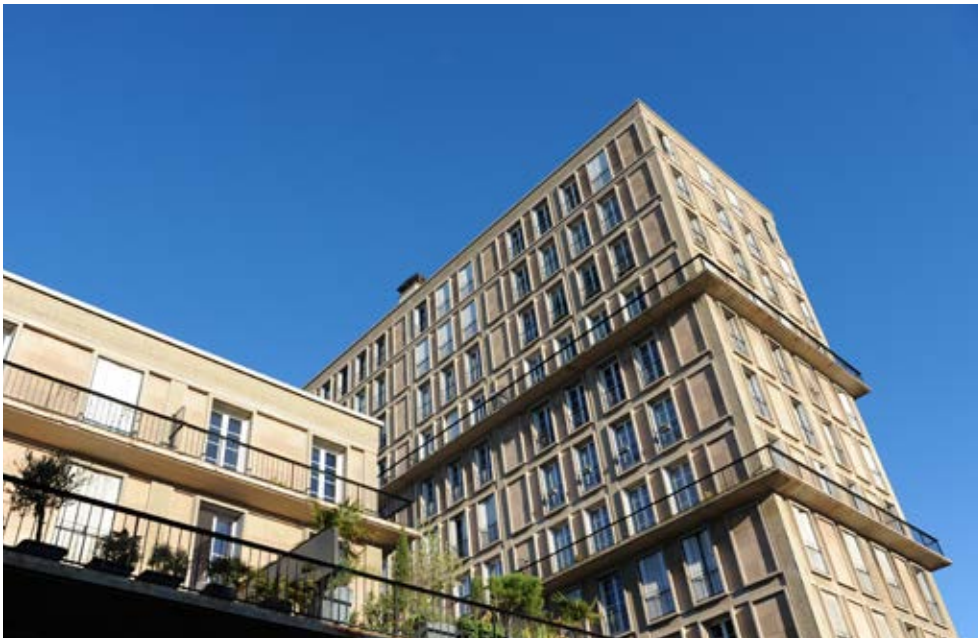
Perret a imposé que chaque côté des constructions mesure 6,24m, soit la portée optimale d'une poutre de béton armé, à l'époque.
