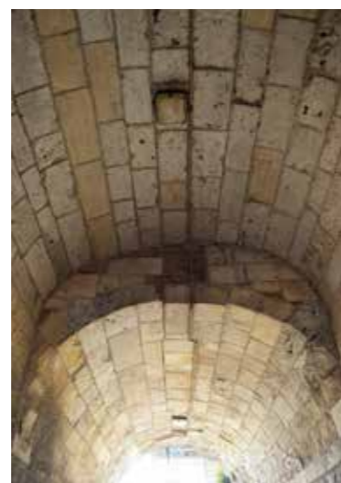
Ill. 11 : Intrados du passage voûté et de la porte du bastion © F. Bonhomme-Inrap.
