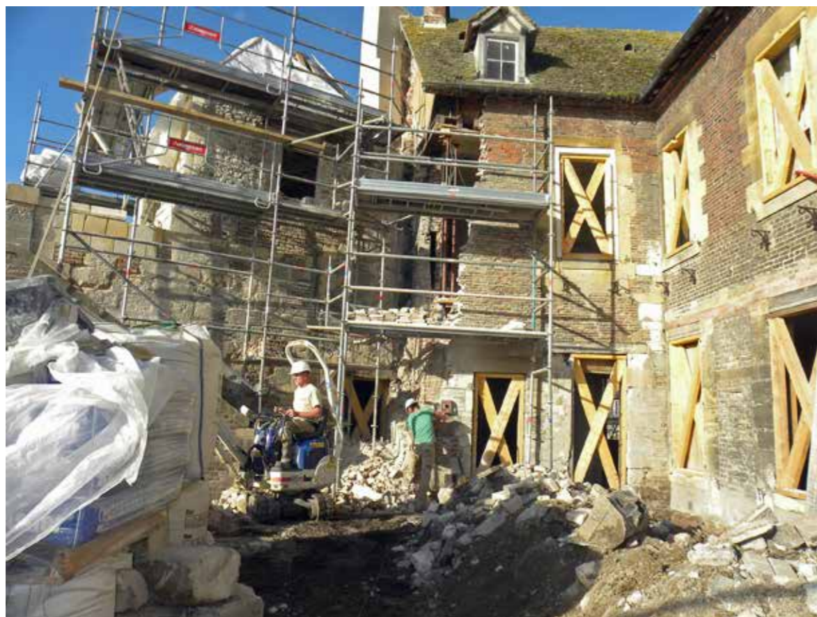
Travaux sur l'aile en retour d'équerre du logis qui se déversait vers la cour, entraînant de profondes fissures. Les interventions ont consisté en une consolidation en sous-œuvre des fondations, un traitement et un rejointoiement des maçonneries (pierres éclatées remplacées, fissures remaillées par incrustation de briques neuves). © Catherine Auger
