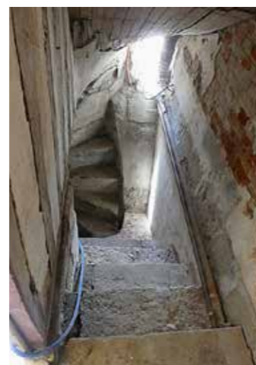
Ill. 12 : Escalier menant à la terrasse et au chemin de ronde du bastion depuis le passage voûté, d'après D. Lefèvre-ACMH. © M. Lallauret-Inrap
