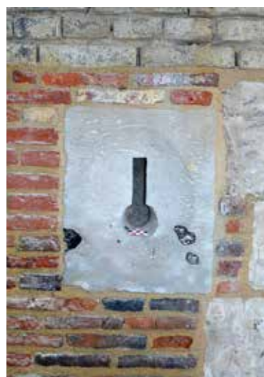
Ill. 10 : Ouverture de tir nord de type arquebusière-mousquetière pour canon à main, parement extérieur du parapet, relevé : F. Bonhomme ; DAO : M. Lallauret-Inrap.
