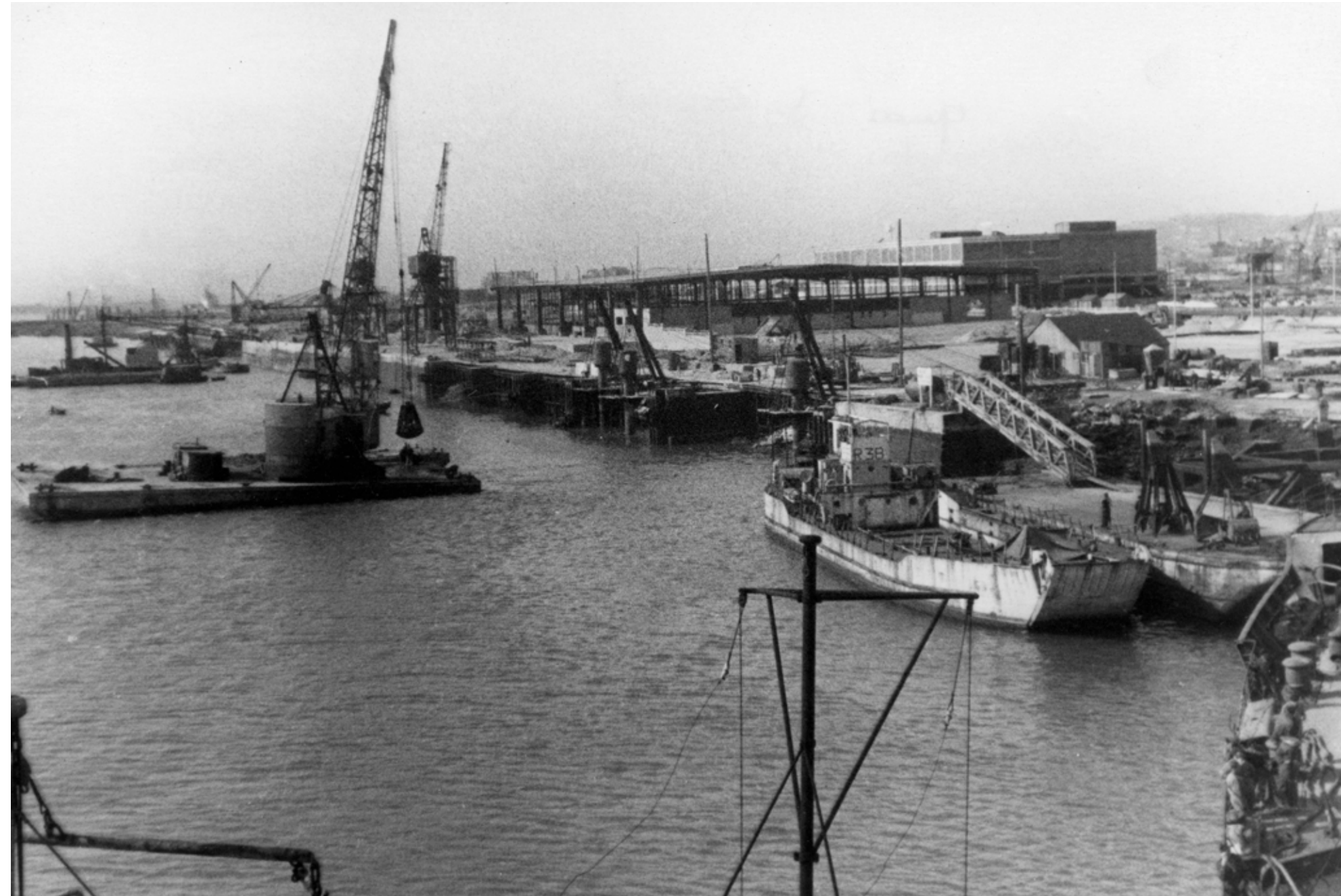
La gare maritime du PAH en construction, quai Joannès-Couvert en 1947.
