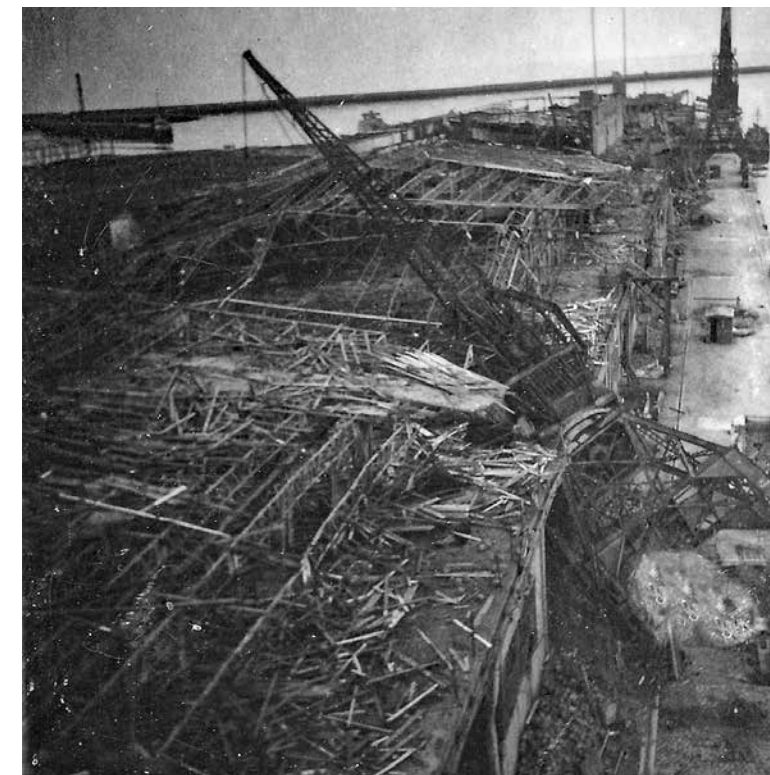
Le quai d'Escale et la carcasse de la gare maritime.
