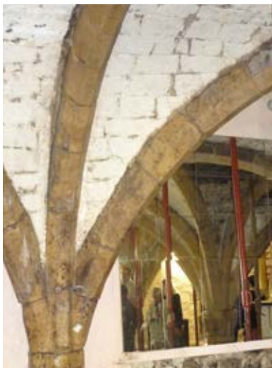
Cave, rue de l'épée : détail d'une voûte.
