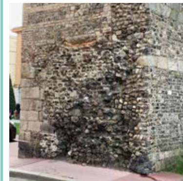
Mur attenant à la porte des Tourelles.
