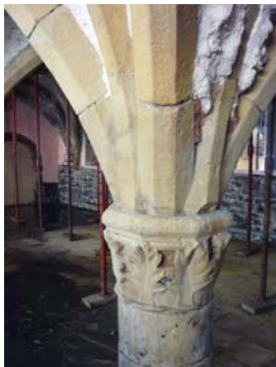
Cave, rue de l'épée : détail d'un pilier du XIII e siècle.
