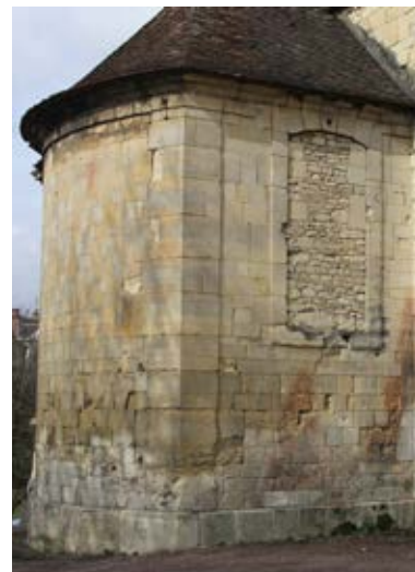
Les murs du XII e siècle de l'église du Saint-Sépulchre, en pierre de Caen.
